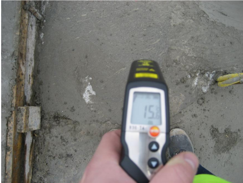
Betona temperatūras kontrolē tā cietēšanas laikā
