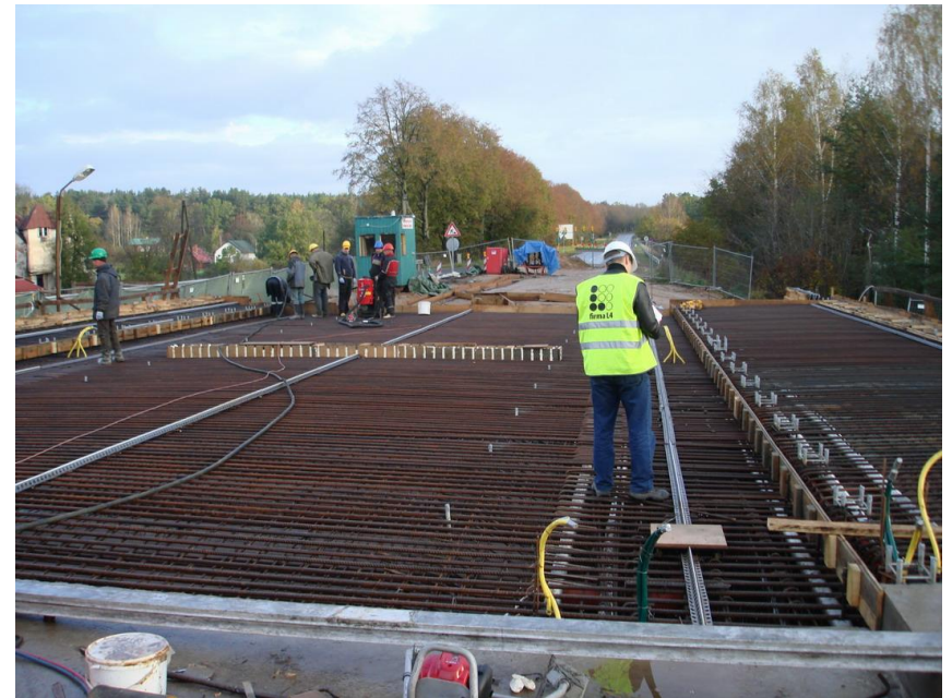
Laiduma segmenta stiegrojuma pieņemšana pirms betonēšanas
