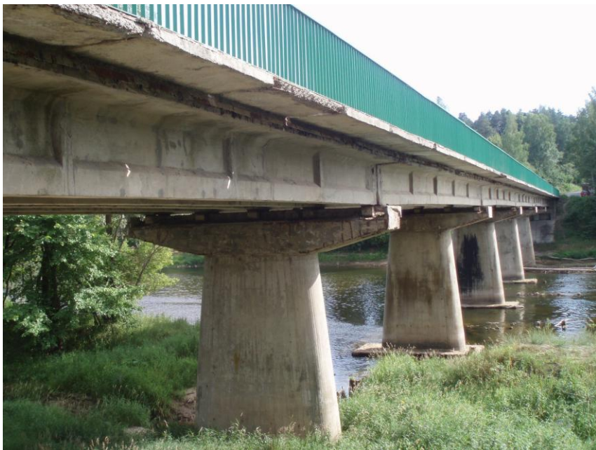
Vecais tilts pār Gauju Murjāņos
