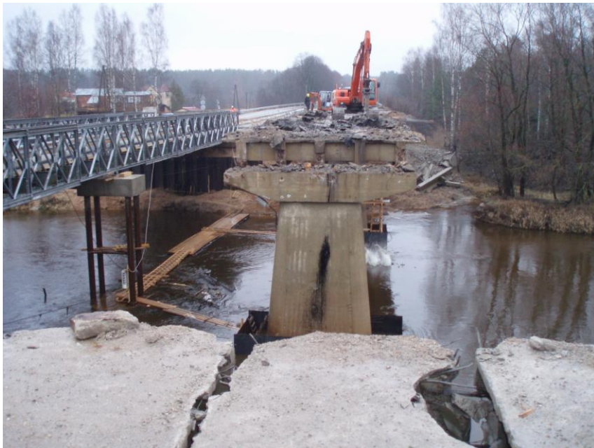
Vecā tilta laiduma konstrukcijas demontāža
