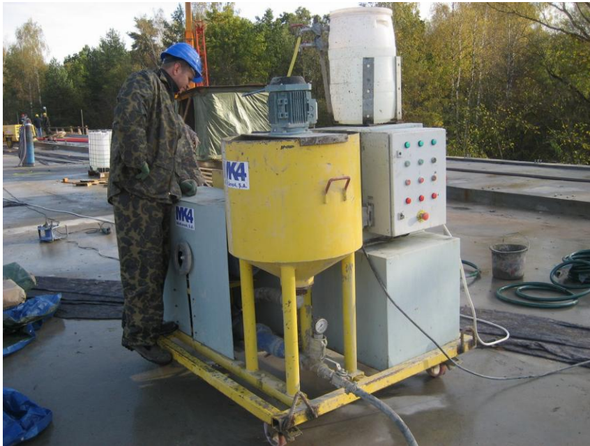
Laiduma saspriegtā stiegrojuma kanālu injicēšana
