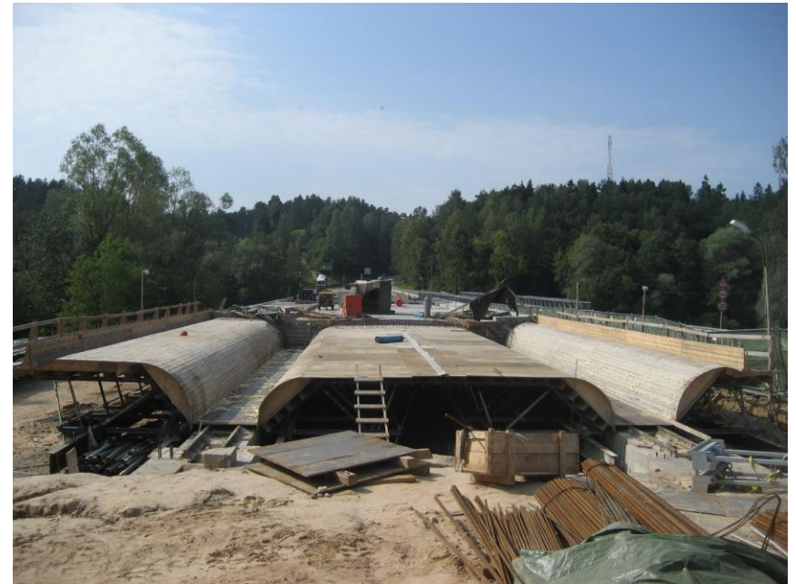
Laiduma konstrukcijas veidņi
