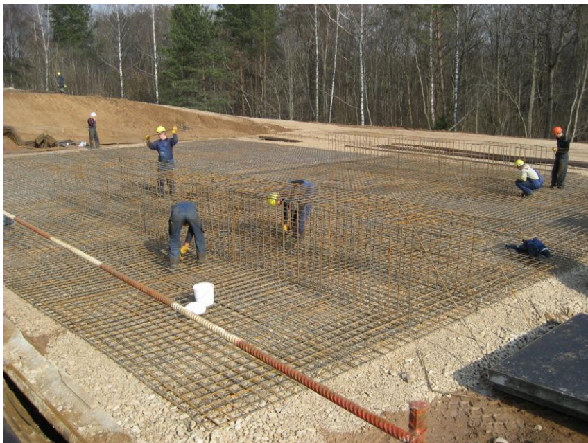
Stāpeļa ( casting yard ) izbūve
