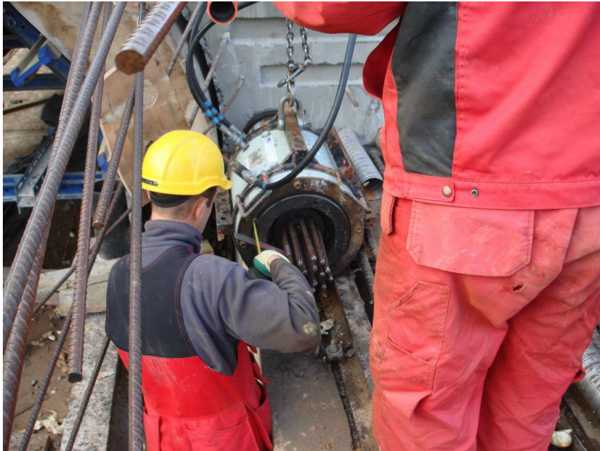
Laiduma segmenta saspriegtā stiegrojuma spriegošana
