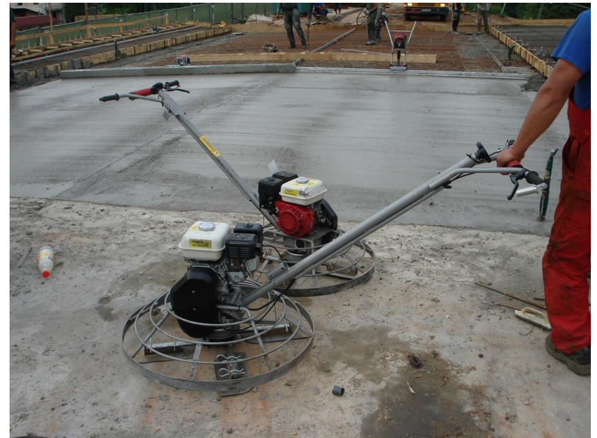
Iekārtas betona virsmas apstrādei pēc iebetonēšanas
