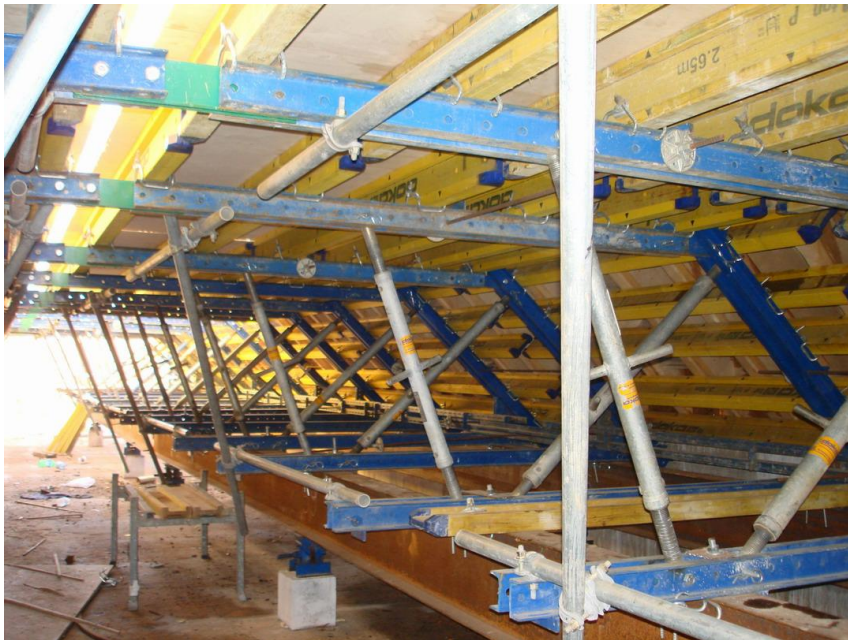
Laiduma konstrukcijas veidņi
