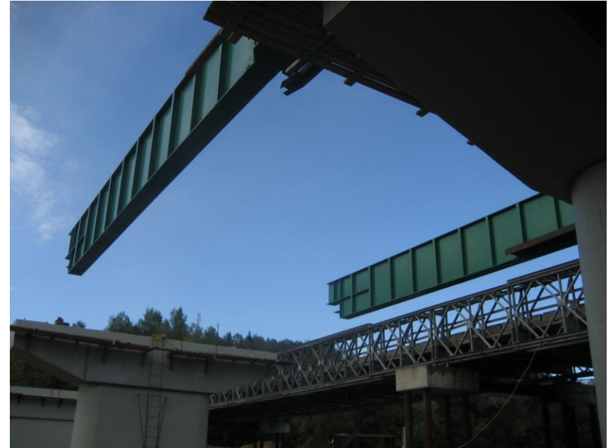
Laiduma bīdīšanas palīgkonstrukcija – avanbeks
