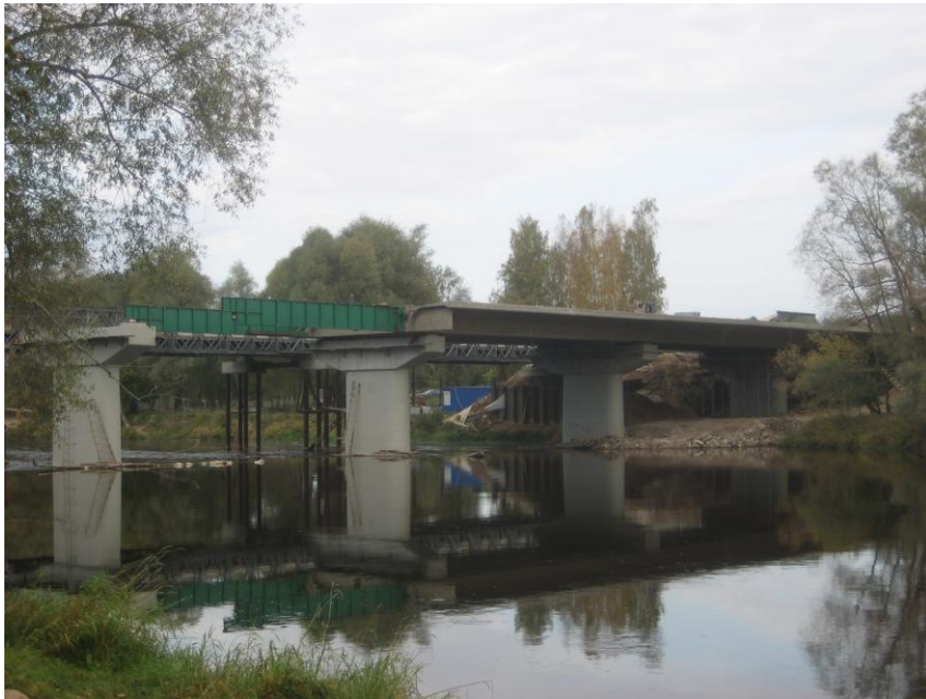
Laiduma bīdīšana (uzbīdīti 4 segmenti)
