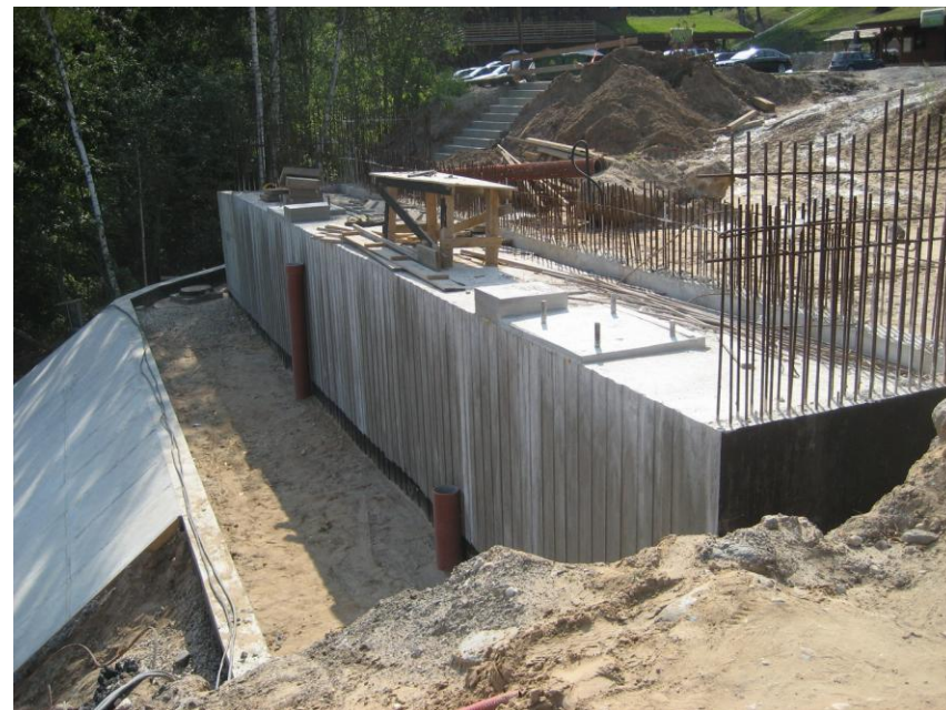
Krasta balsta izbūve (Rīgas krasts)
