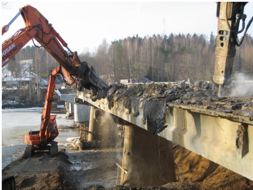
Vecā tilta laiduma konstrukcijas demontāža
