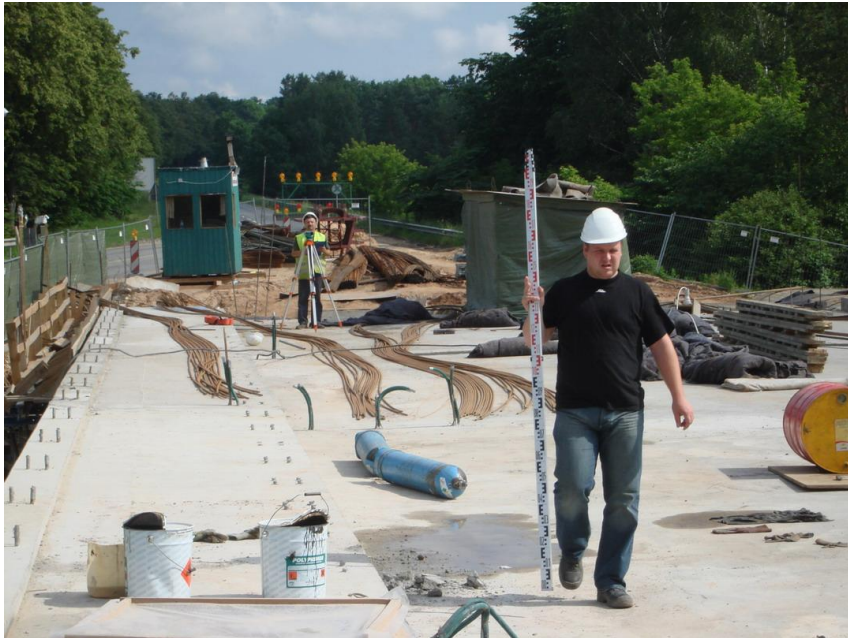
Laiduma konstrukcijas nivelēšana (izlieču pārbaude)
