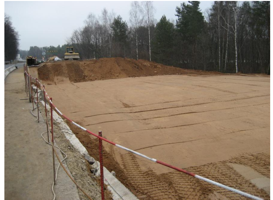
Stāpeļa ( casting yard ) laukuma izbūve
