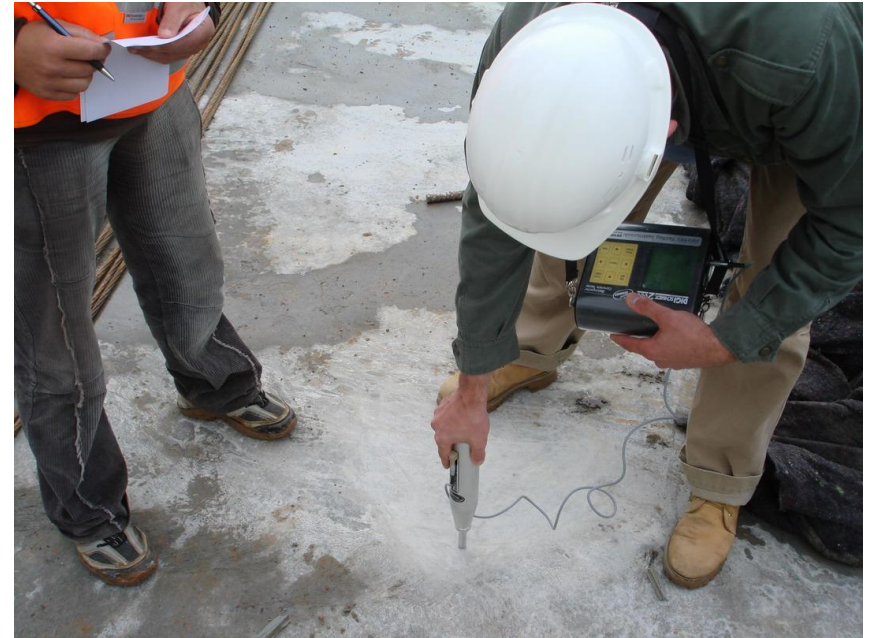
Betona stiprības pārbaude ar Šmidta āmuru
