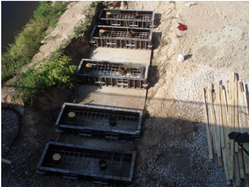
Pagaidu tilta krasta balsta pēda
