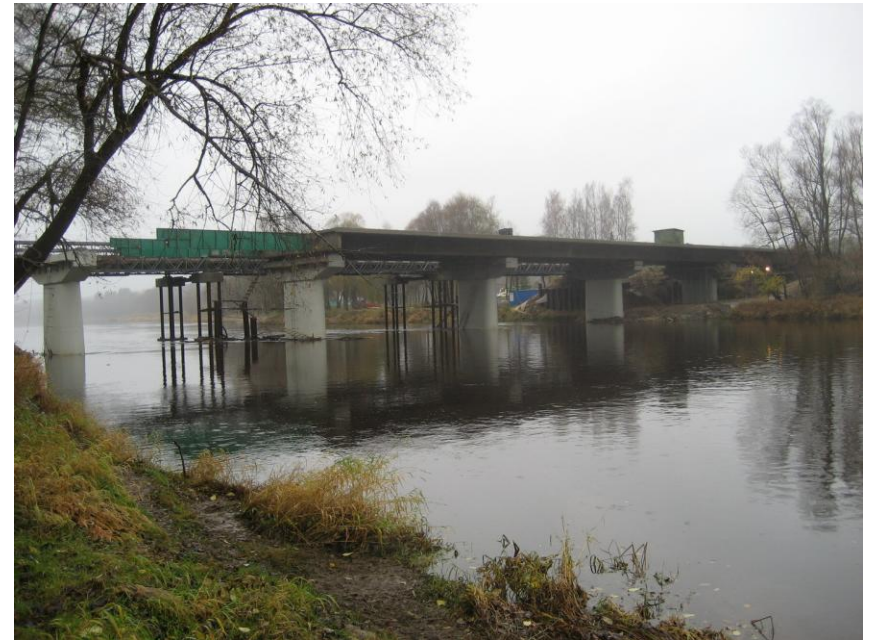
Laiduma bīdīšana (uzbīdīti 5 segmenti)
