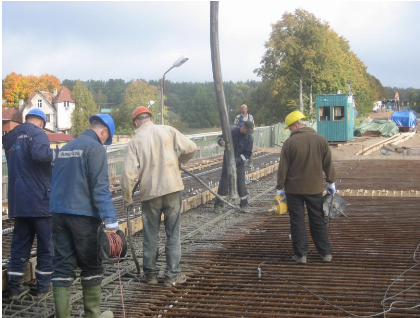
Laiduma segmenta betonēšana
