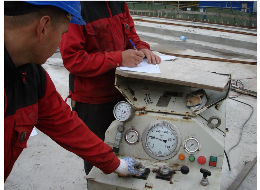
Laiduma segmenta saspriegtā stiegrojuma spriegošana
