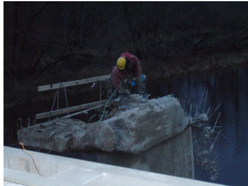
Vecā tilta balsta uzkalas demontāža
