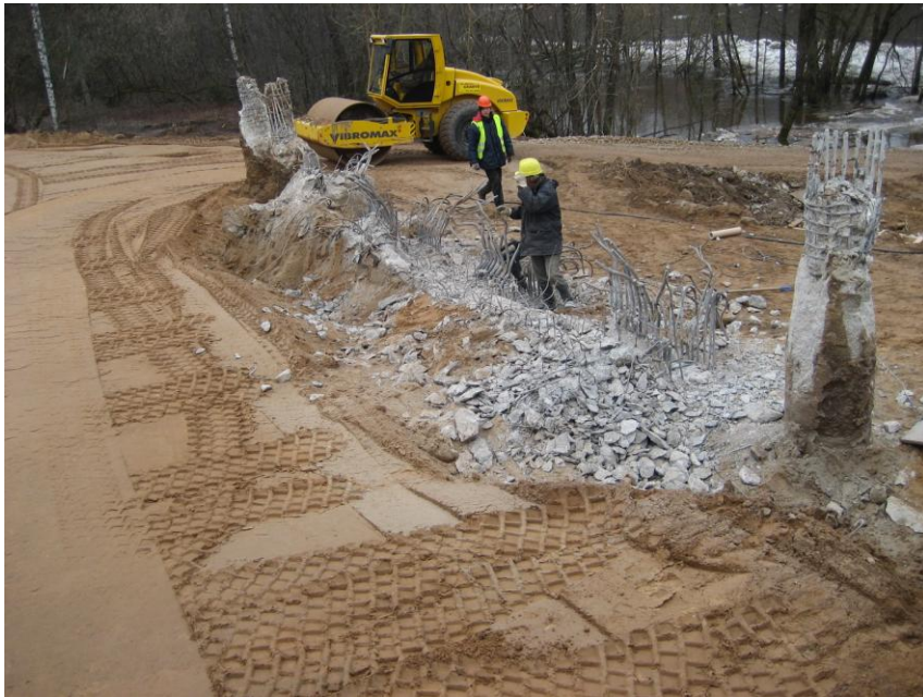
Jaunā krasta balsta izbūve (Murjāņu krasts)
