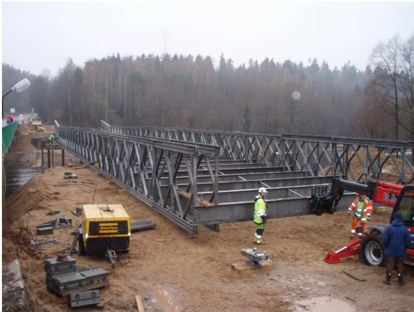
Pagaidu tilta laiduma konstrukcijas montāža
