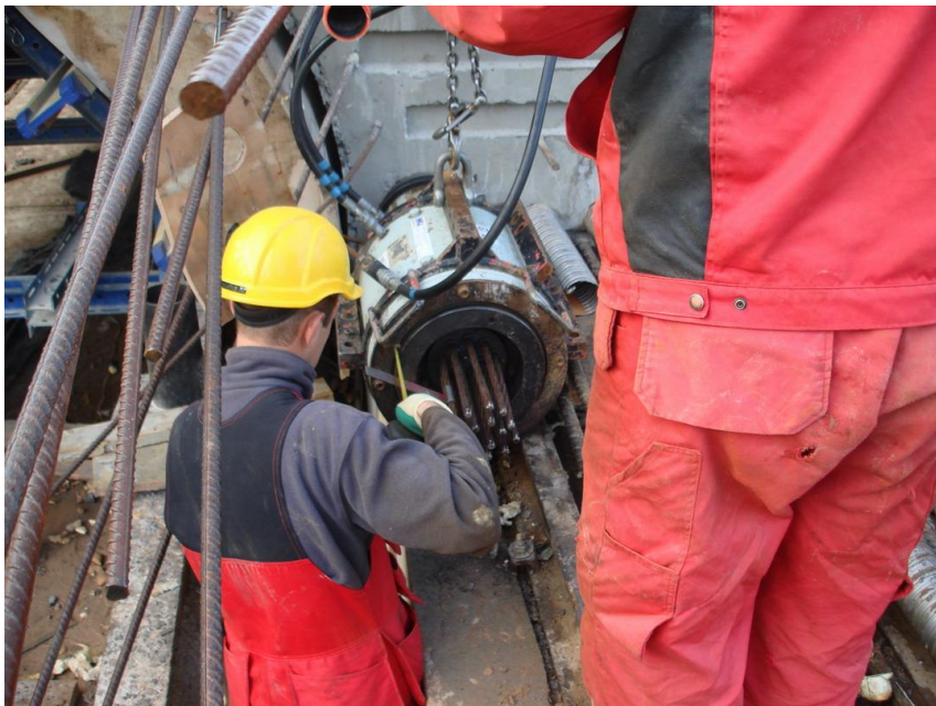
Laiduma segmenta saspriegtā stiegrojuma spriegošana
