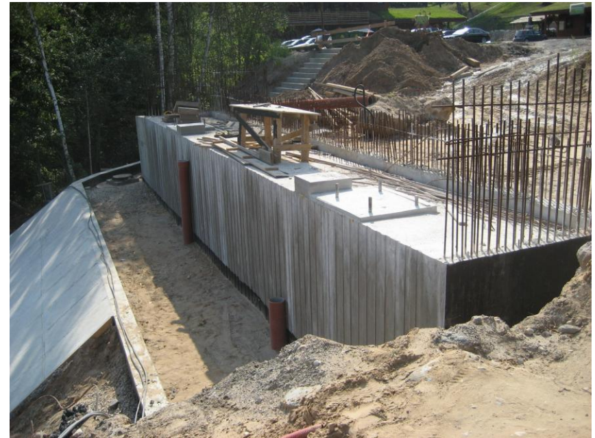
Krasta balsta izbūve (Rīgas krasts)
