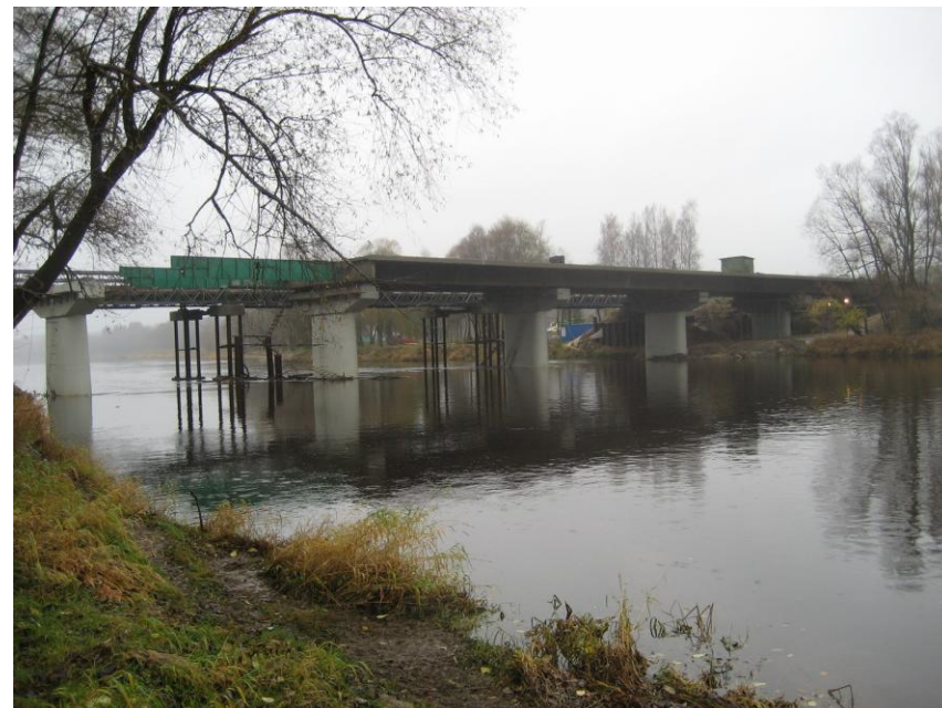
Laiduma bīdīšana (uzbīdīti 5 segmenti)
