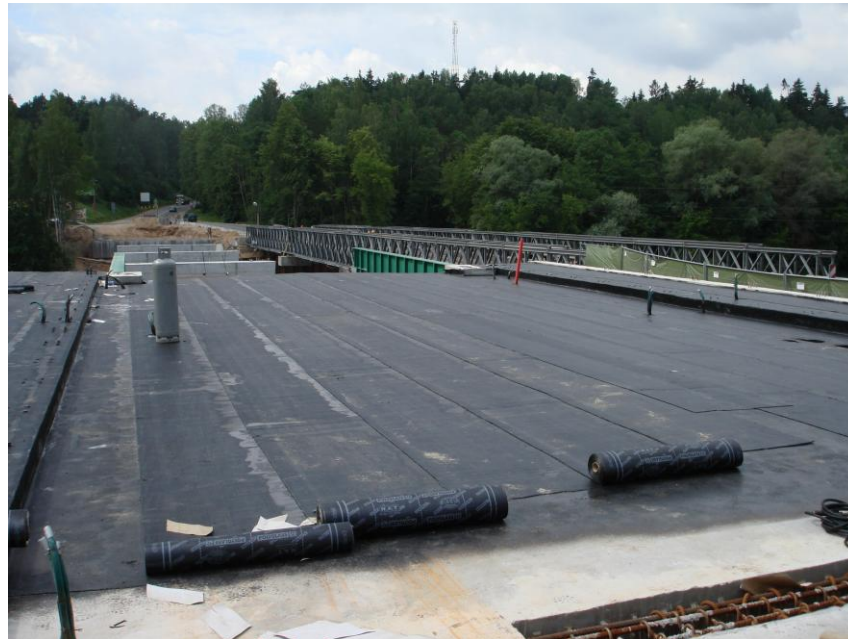
Hidroizolācija
