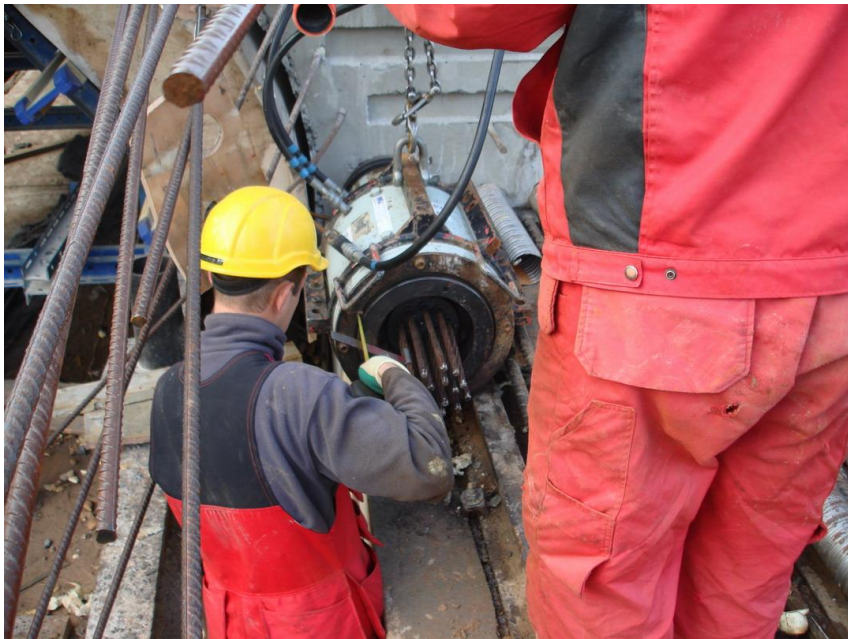
Laiduma segmenta saspriegtā stiegrojuma spriegošana
