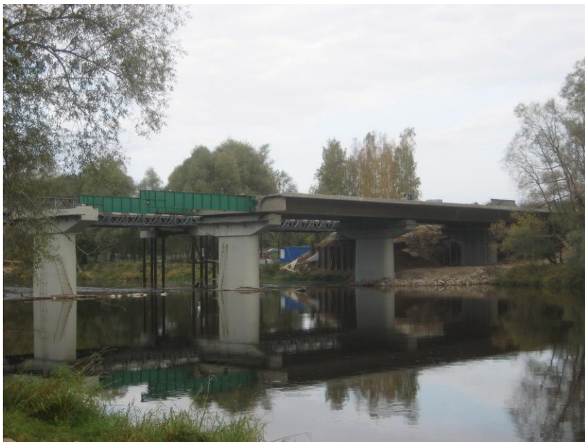
Laiduma bīdīšana (uzbīdīti 4 segmenti)
