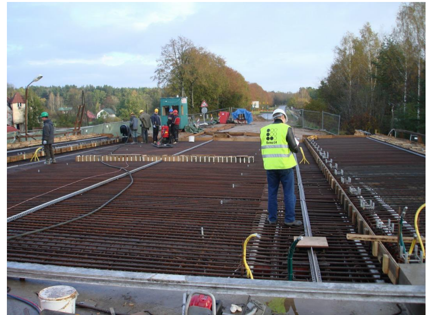
Laiduma segmenta stiegrojuma pieņemšana pirms betonēšanas
