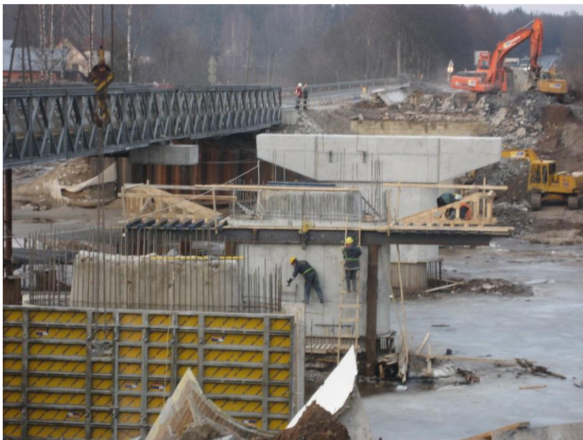
Jaunā tilta balstu izbūves etapi
