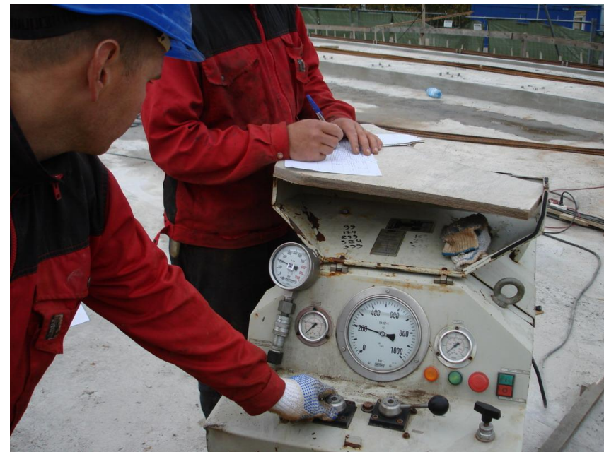
Laiduma segmenta saspriegtā stiegrojuma spriegošana
