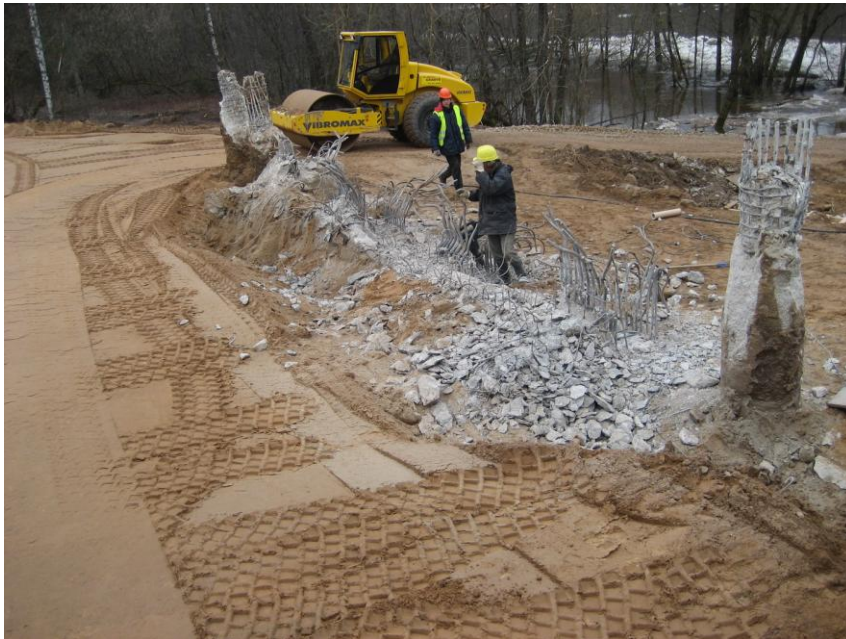
Jaunā krasta balsta izbūve (Murjāņu krasts)
