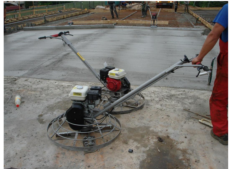
Iekārtas betona virsmas apstrādei pēc iebetonēšanas
