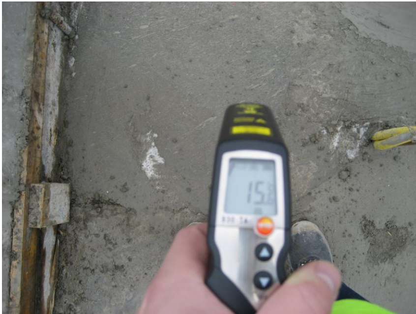
Betona temperatūras kontrolē tā cietēšanas laikā
