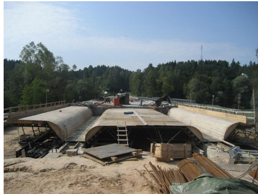
Laiduma konstrukcijas veidņi
