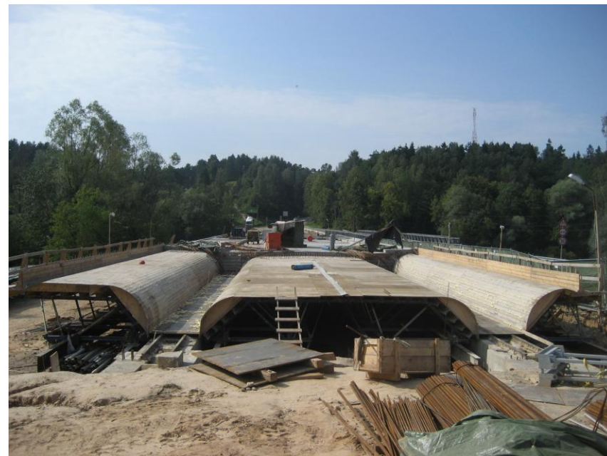
Laiduma konstrukcijas veidņi
