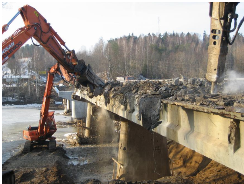
Vecā tilta laiduma konstrukcijas demontāža
