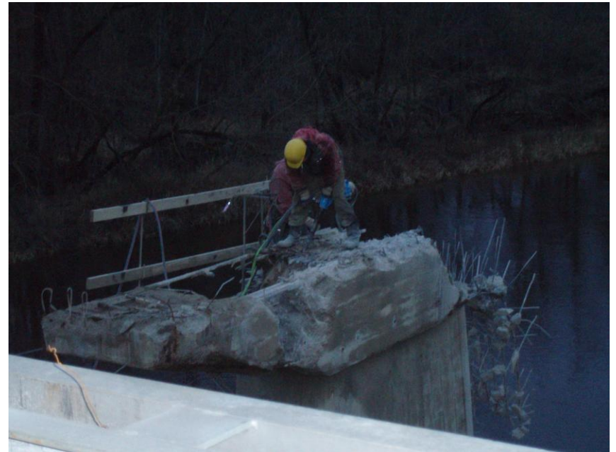
Vecā tilta balsta uzkalas demontāža
