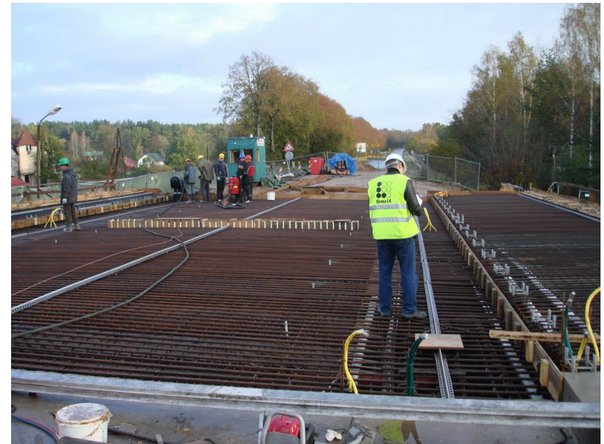
Laiduma segmenta stiegrojuma pieņemšana pirms betonēšanas
