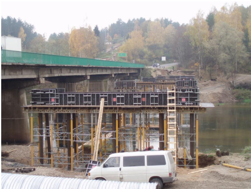
Pagaidu tilta balstu izbūve
