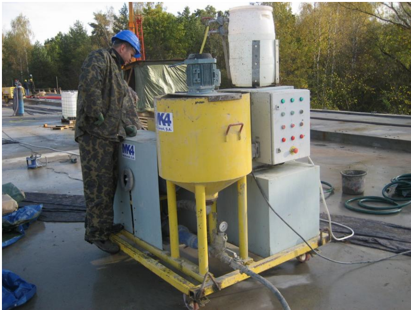
Laiduma saspriegtā stiegrojuma kanālu injicēšana
