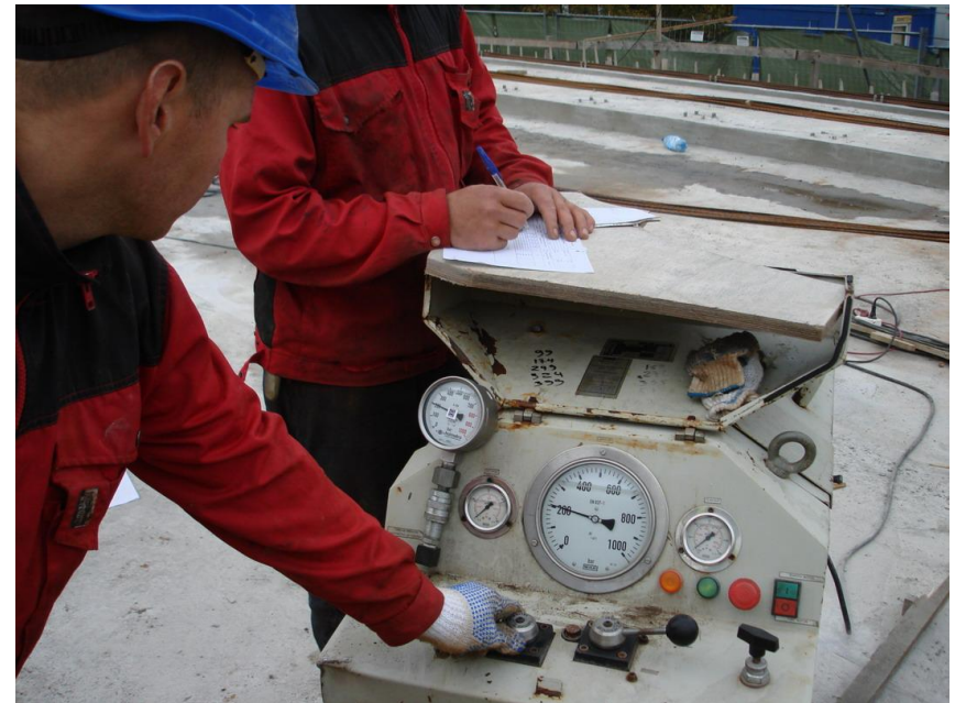
Laiduma segmenta saspriegtā stiegrojuma spriegošana
