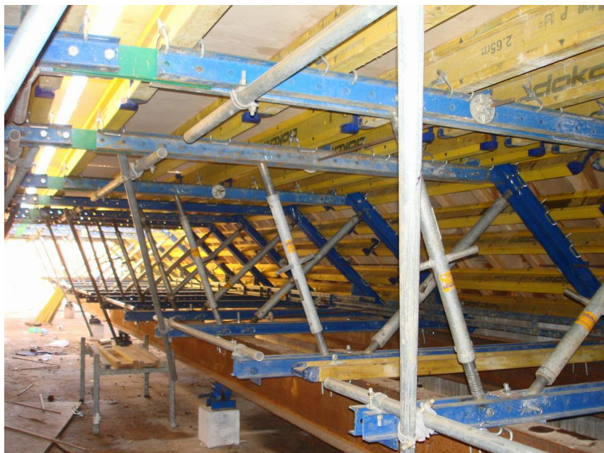
Laiduma konstrukcijas veidņi
