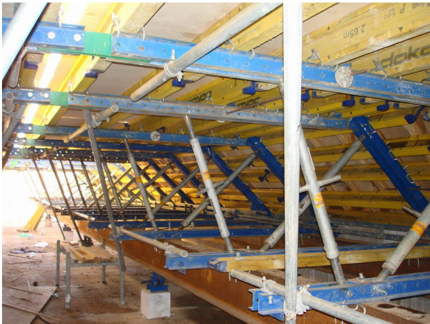
Laiduma konstrukcijas veidņi
