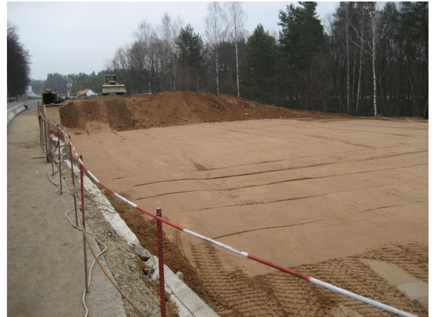
Stāpeļa ( casting yard ) laukuma izbūve
