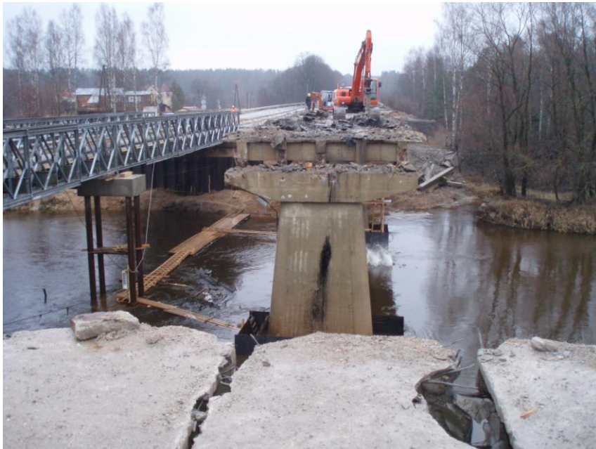
Vecā tilta laiduma konstrukcijas demontāža
