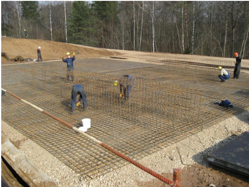
Stāpeļa ( casting yard ) izbūve
