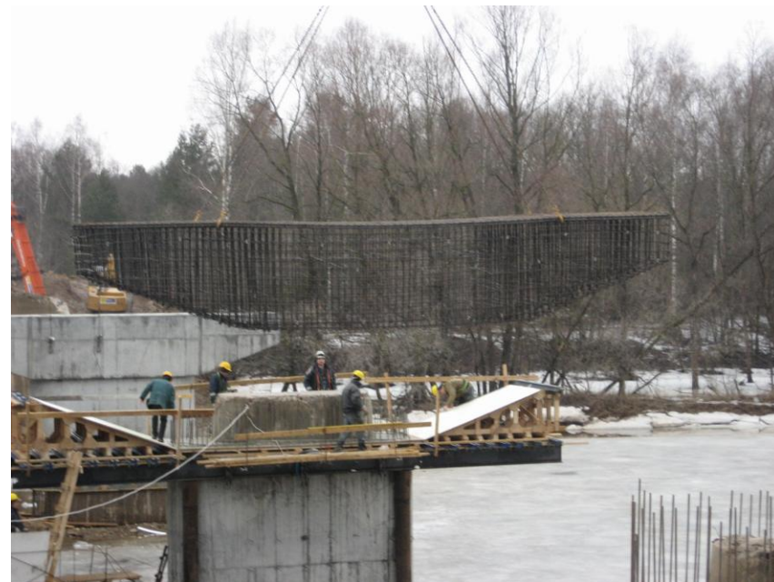
Jaunā balsta rīģeļa stiegrojuma karkasa montāža
