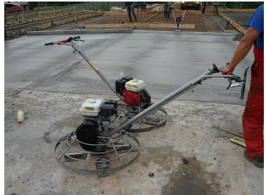
Iekārtas betona virsmas apstrādei pēc iebetonēšanas
