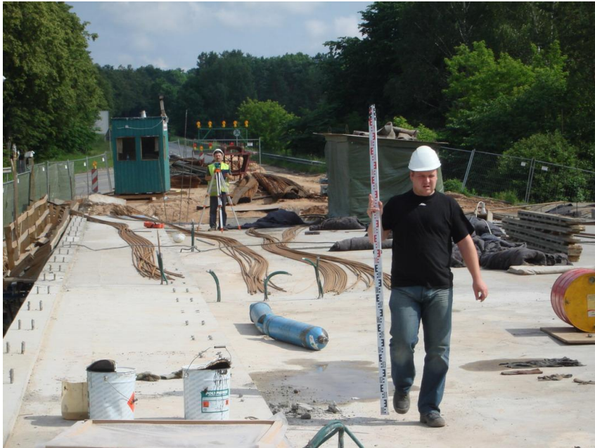
Laiduma konstrukcijas nivelēšana (izlieču pārbaude)
