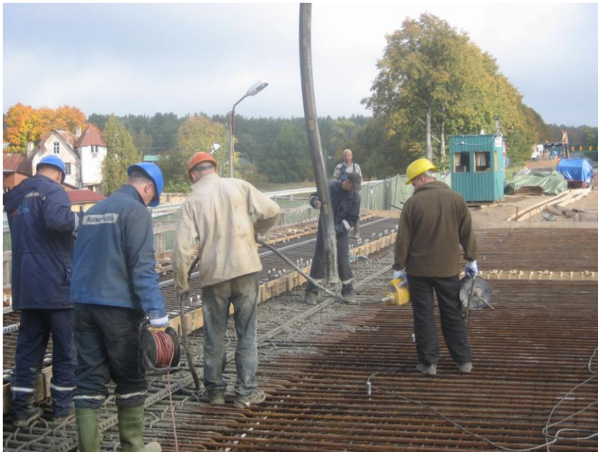
Laiduma segmenta betonēšana
