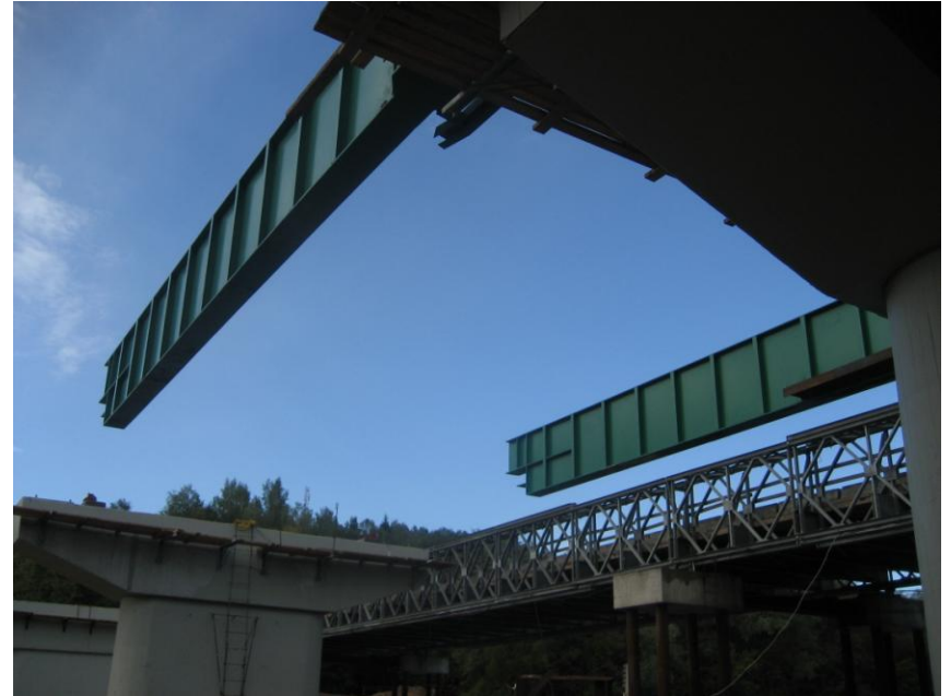
Laiduma bīdīšanas palīgkonstrukcija – avanbeks
