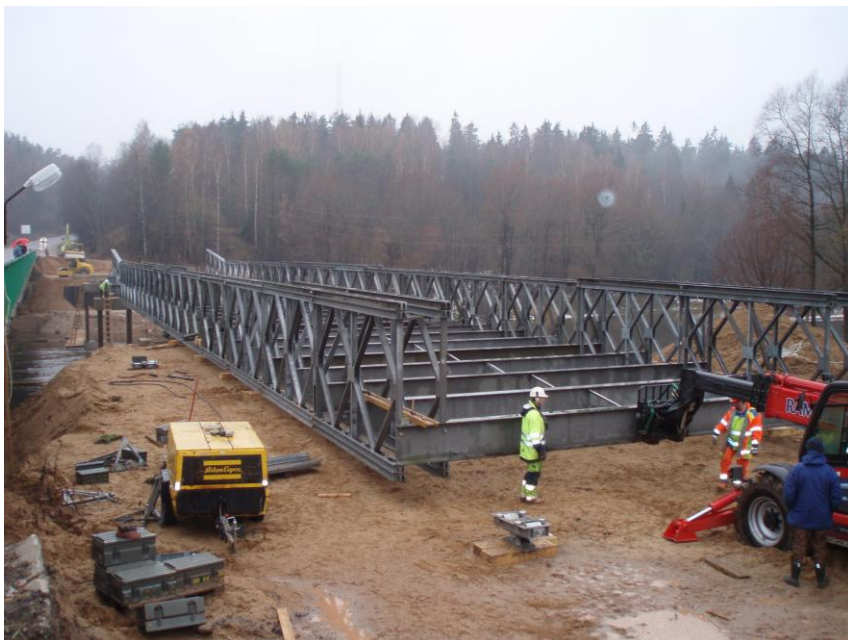
Pagaidu tilta laiduma konstrukcijas montāža
